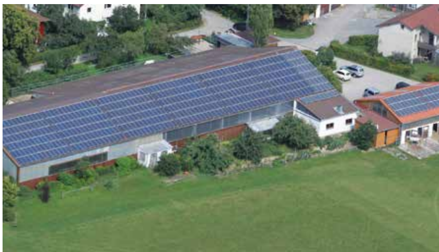
Gäufelden-Nebringen - Niemcy Instalacja: 31,85 kW | Speedrail
