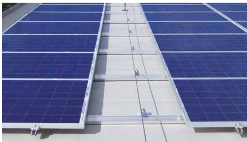
Elpo | Frubona terlan - Włochy Instalacja: 671,86 kW | System wkrętów dwugwintowych
